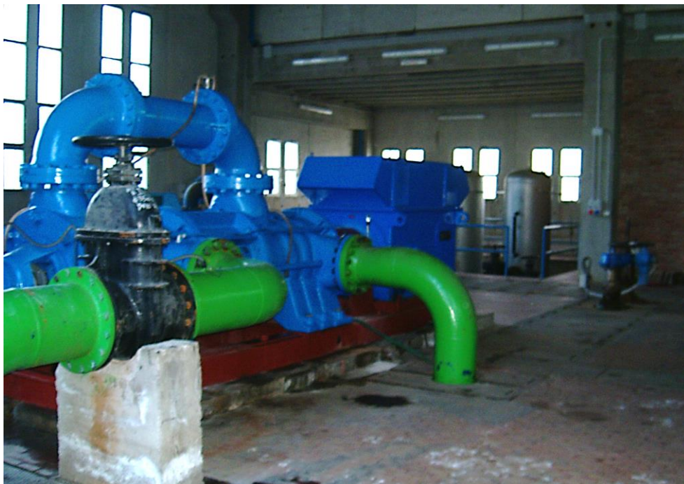
Fig. 3 Elettropompa Marelli con basamento da 250 l/s lato aspirazione/mandata ISI Aggia
