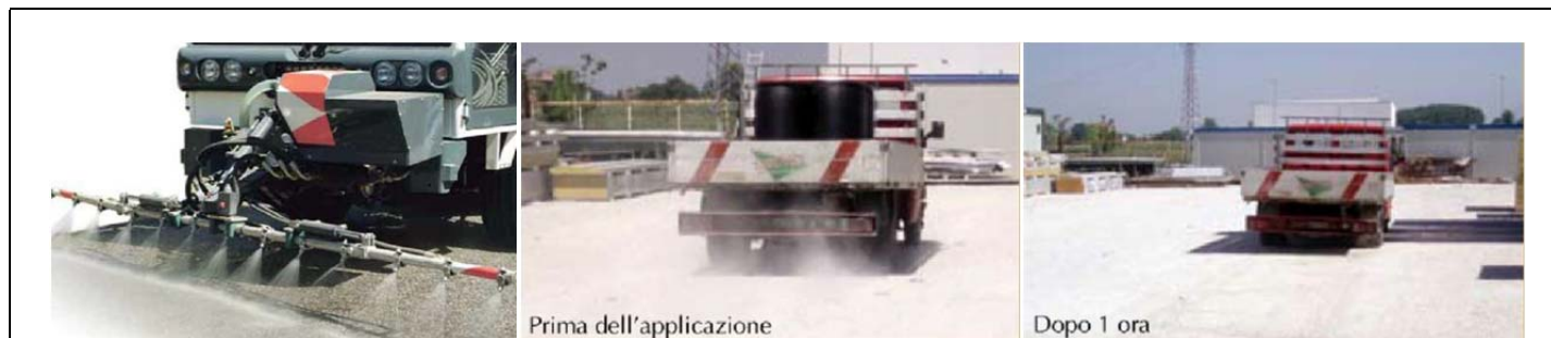
Fig. 9 – Trattamento antipolvere delle piste di cantiere e dei piazzali di manovra.
