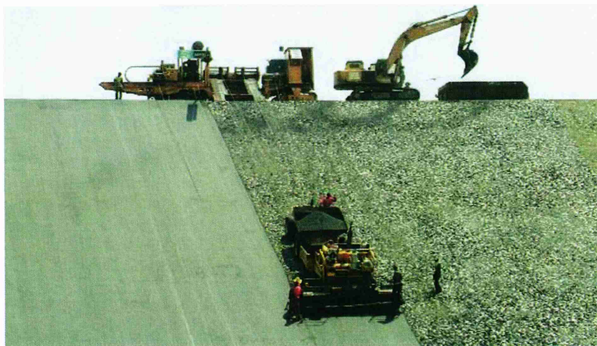
Fig. 5b - Il carro argani principale assicura la finitrice, il dumper ed un rullo
