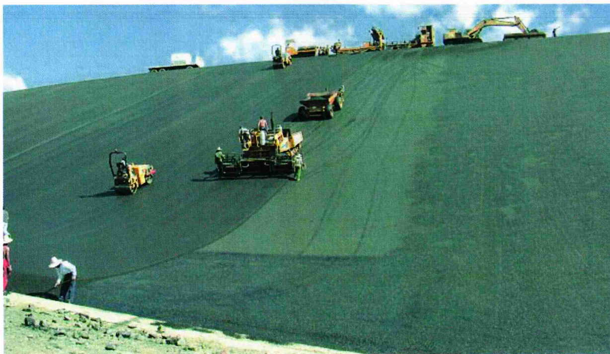
Fig. 5a - Visione d'insieme dei macchinari in operazione durante una stesa
