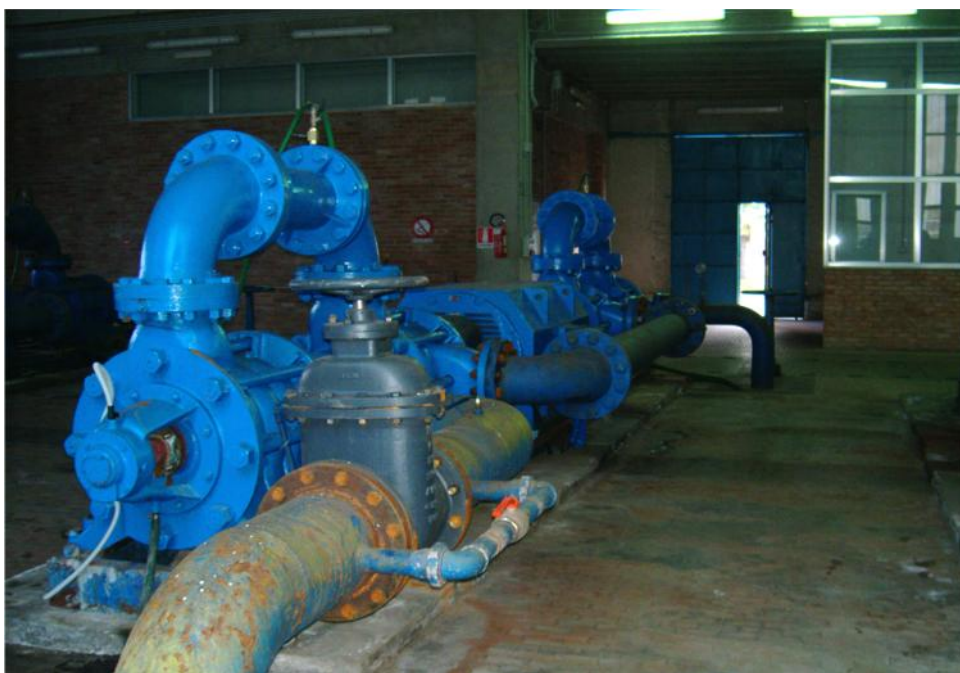
Fig. 4 bis Vista retro motore direzione premente Elettropompa con basamento Marelli da 100 l/s ISI Aggia
