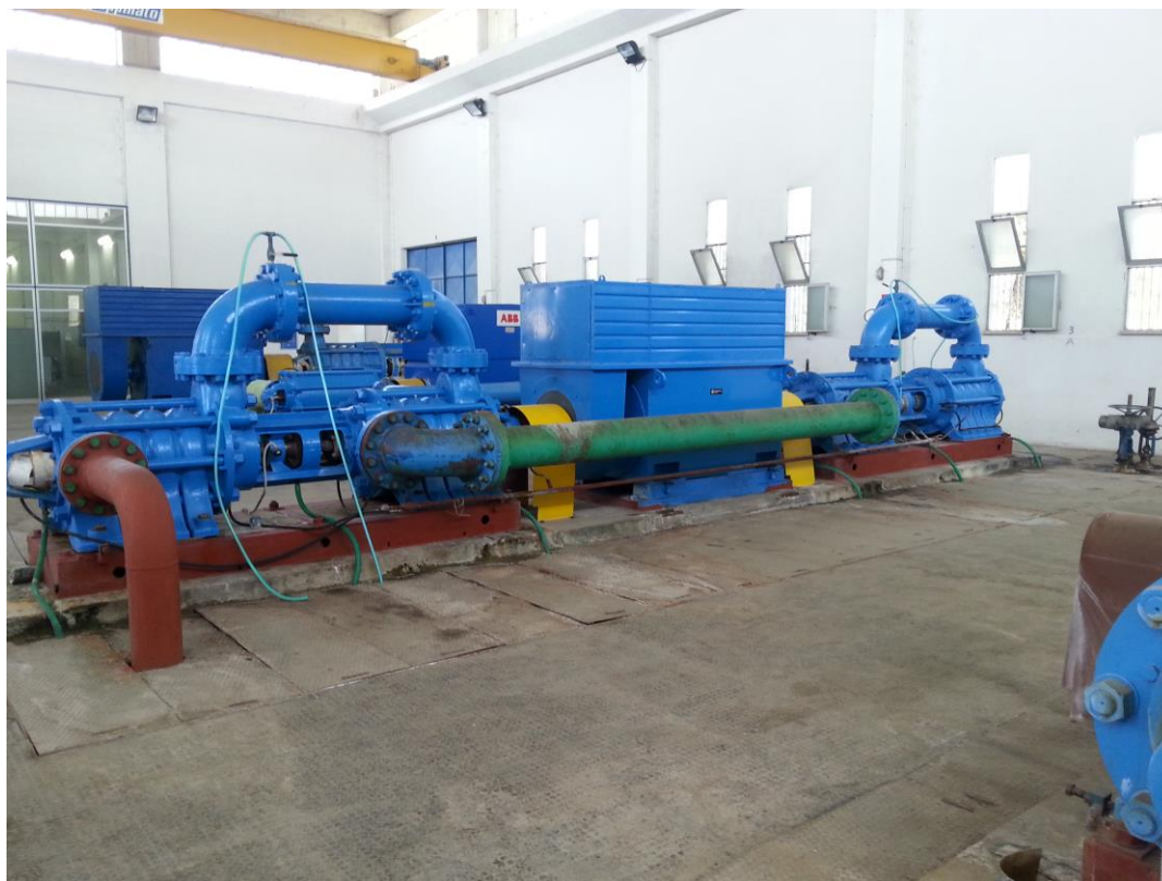
Fig. 4 Vista Elettropompe con basamento Rotos e Marelli da 100 l/s ISI Pietrasasso
