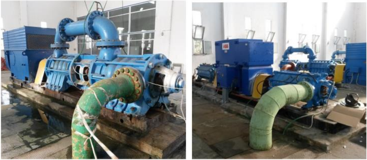
Fig. 2 Vista lati mandata e aspirazione elettropompa da 160 l/s e da 100 l/s ISI Pietrasasso
