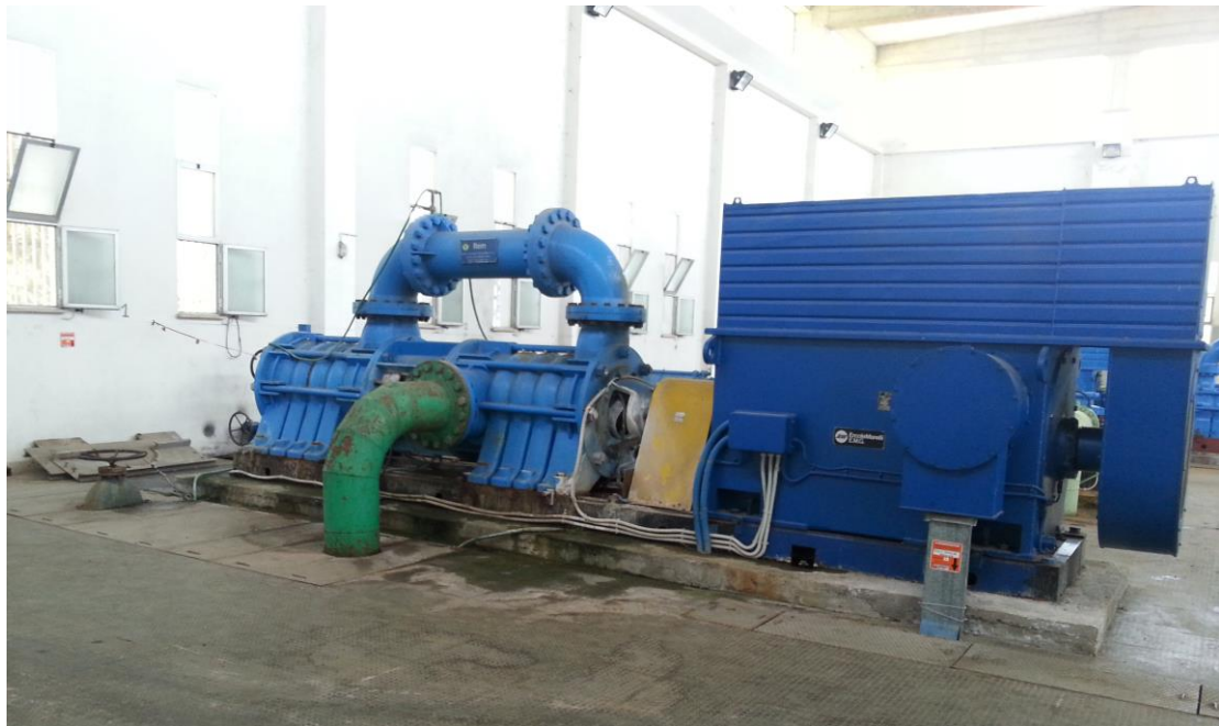
Fig. 3 Elettropompa Marelli con basamento da 160 l/s ISI Pietrasasso
