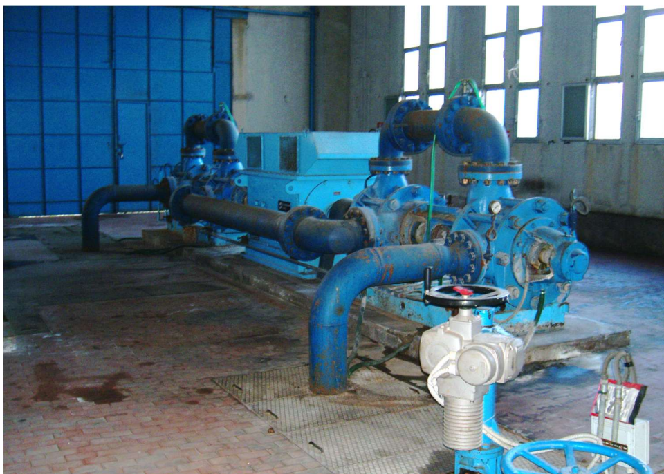
Fig. 4 Elettropompa con basamento Marelli da 50 l/s ISI Aggia
