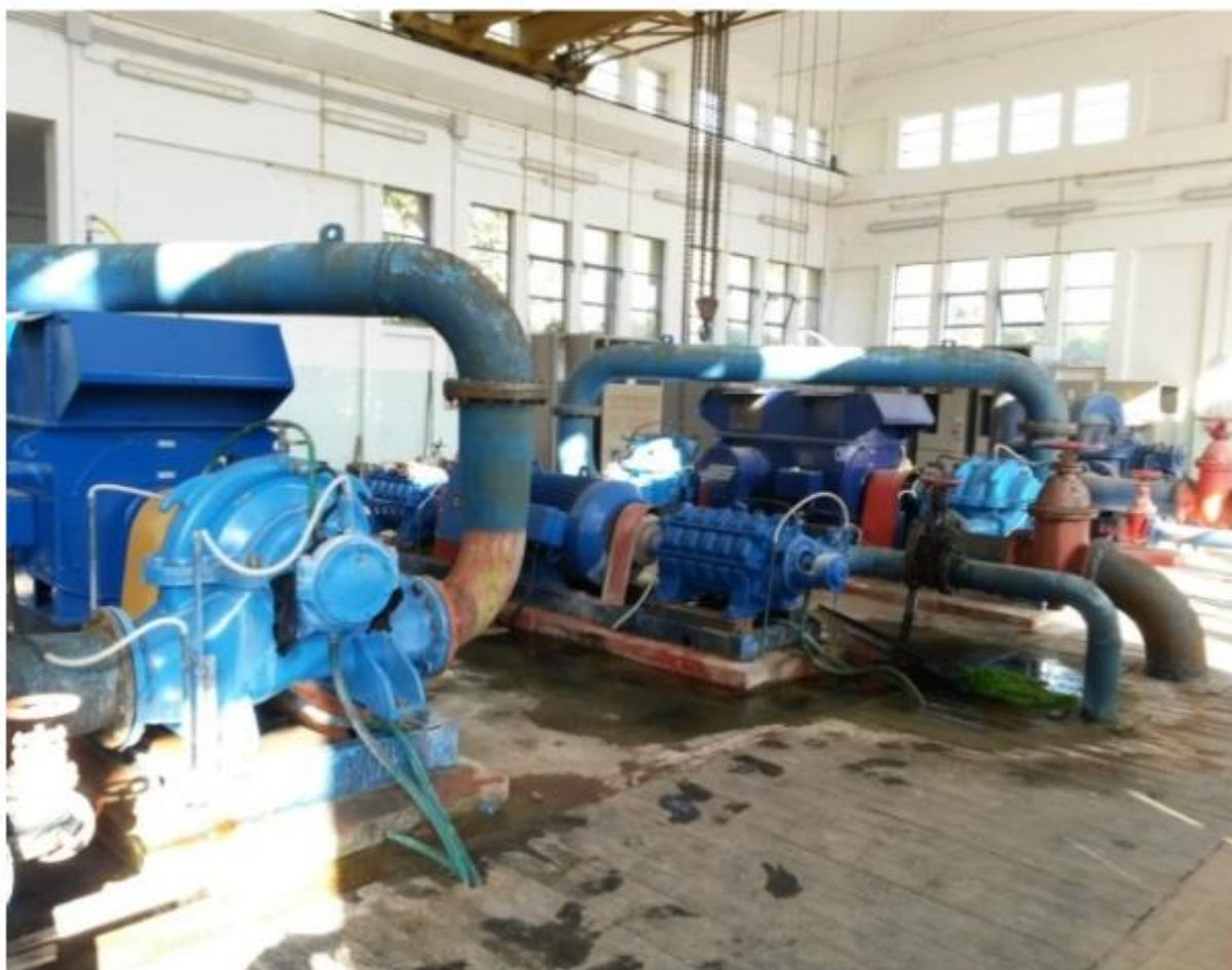
Fig. 3 Elettropompa Marelli multicellulare con basamento lato aspirazione ISI Ginestrole
