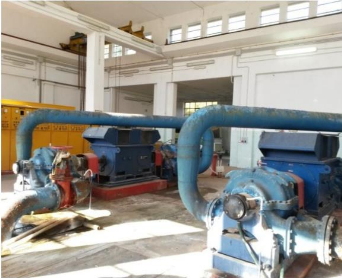
Fig. 2 Vista elettropompe Marelli lato aspirazione ISI Ginestrole
