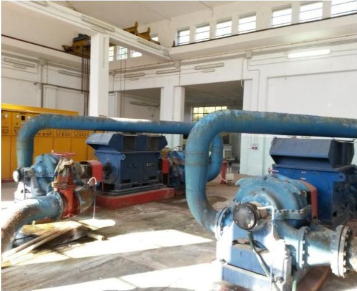
Fig. 2 Vista elettropompe Marelli lato aspirazione ISI Ginestrole
